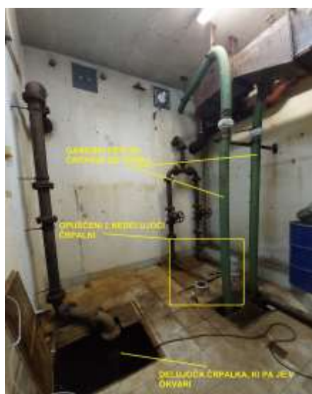
Slika – strojnica C3, trenutno stanje
